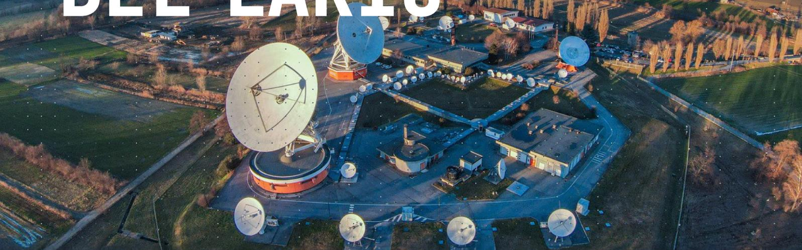
Il Centro spaziale del Lario di Telespazio, attivo dal 1977, è situato a Nord del Lago di Como, nei pressi del comune di Gera Lario. Occupa un'area totale di 80.000 metri quadrati, di cui 5.000 coperti. All'interno del Centro sono operative oltre 60 antenne in grado di gestire servizi di trasmissione e ricezione satellitare.
